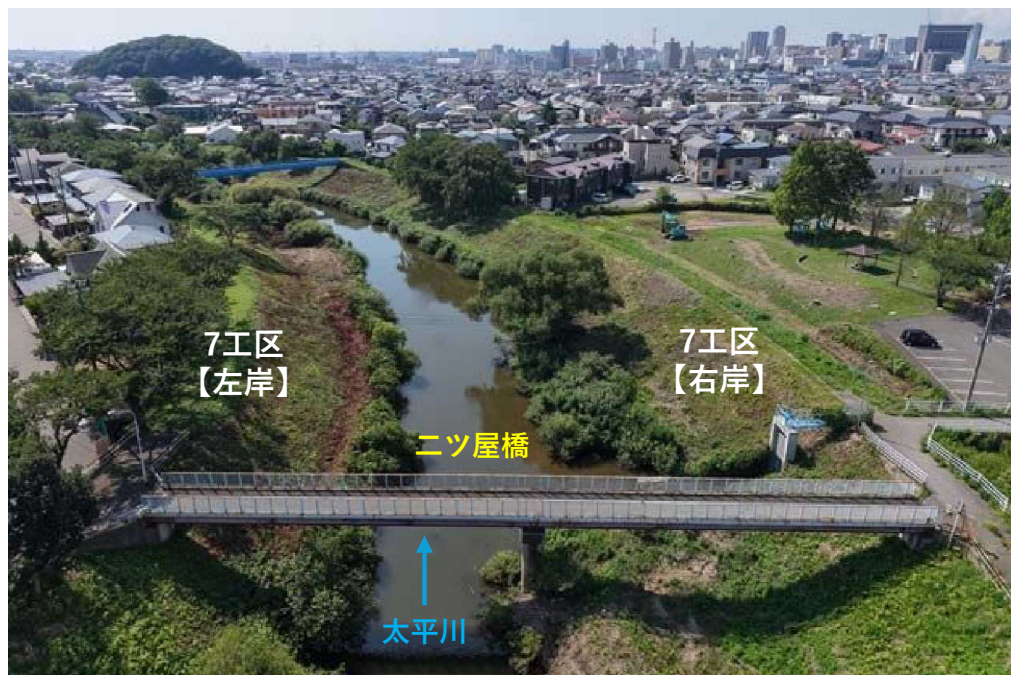
【写真①】ニツ屋橋の下流側 【着手前】
