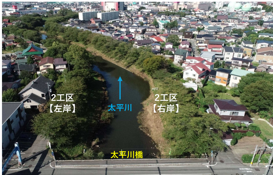
【写真①】 太平川橋の下流側【着手前】
