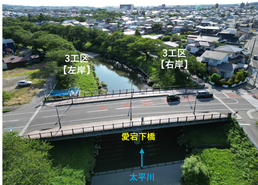
【写真①】 愛宕下橋の下流側【着手前】
