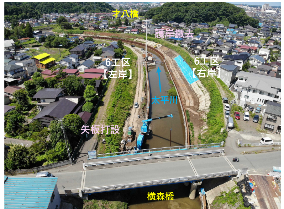
【写真②】 横森橋下流側 【R8.6月撮影】
