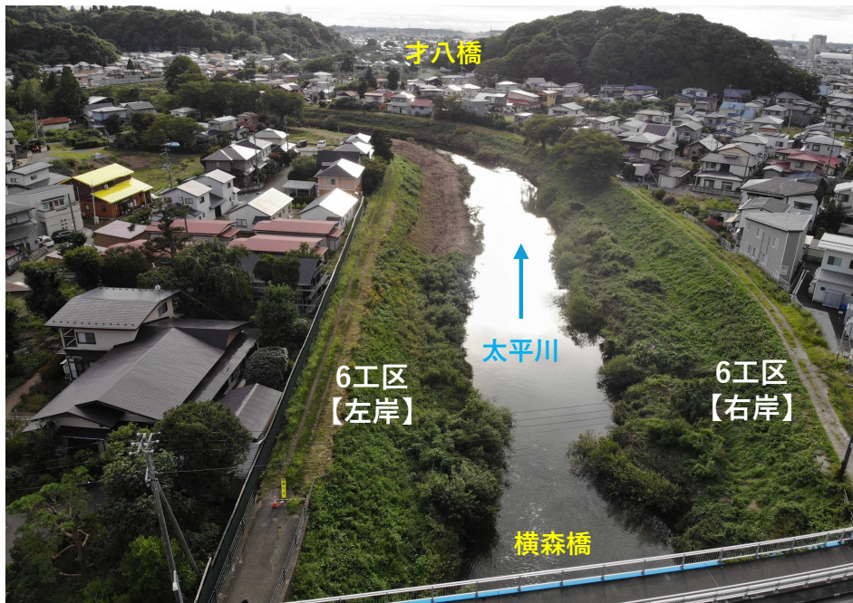
【写真①】 横森橋下流側 【着手前】
