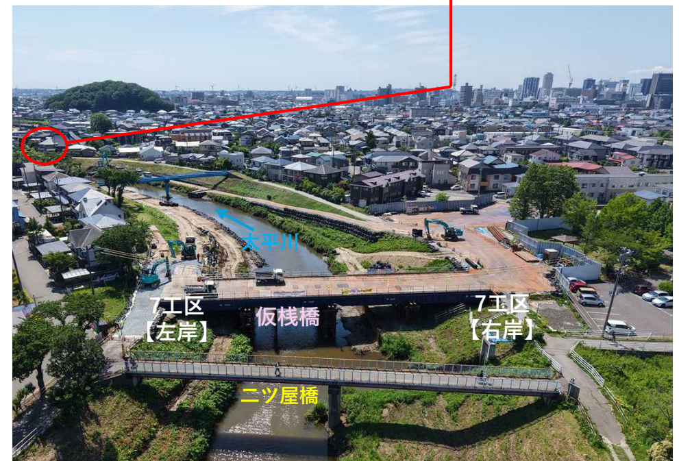
【写真②】ニツ屋橋の下流側 【R8.6月撮影】
