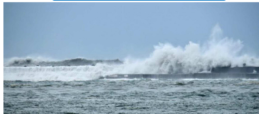
防波堤により荒天時の波浪等から港内静穏度を確保
