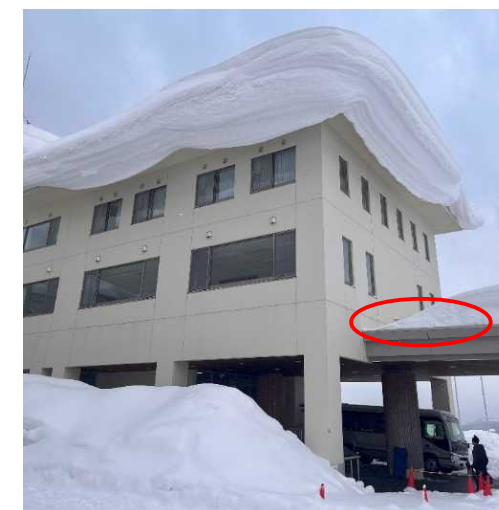
玄関フロント前せり出し屋根
