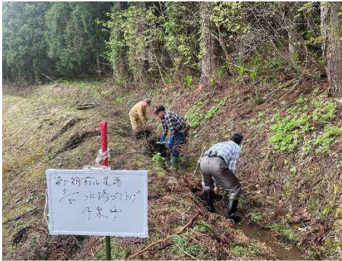
土水路の泥上げ
