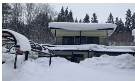
豪雪の状況（鹿角市）
