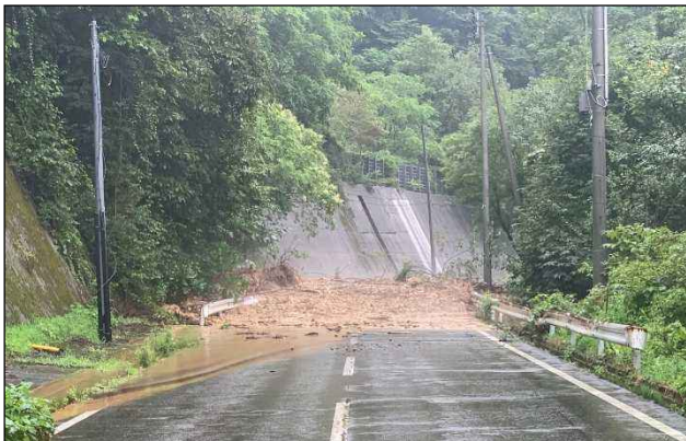
R 7年8月豪雨により山地から国道341号線に土砂が流出（仙北市）
