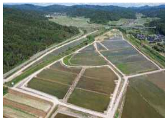
【整備後の全景】
