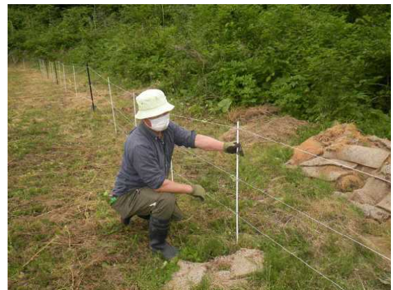
〈図〉電気柵の設置作業
