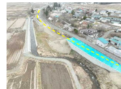
工事が進む現道拡幅区間
