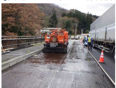
橋面防水による漏水防止
