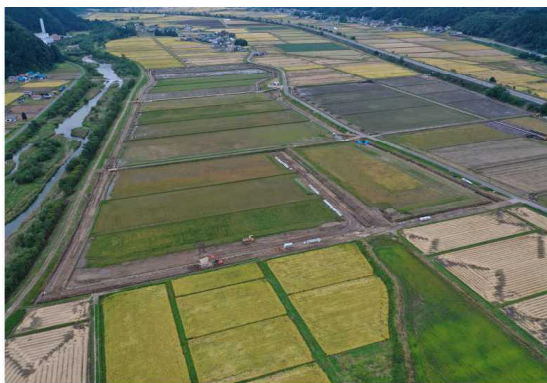
【毛馬内北部地区： 全景（令和7年度工事実施区域）】
