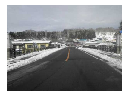
舗装復旧 橋面補修の完成
