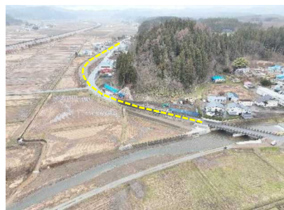
工事が進む線形改良区間
