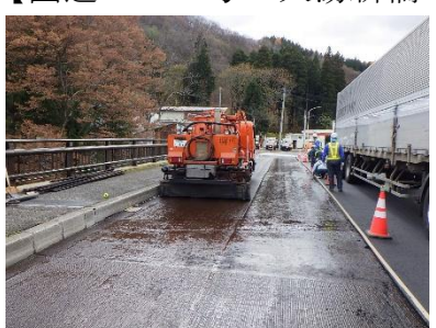
橋面防水による漏水防止
