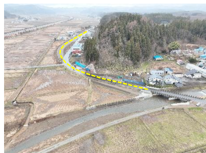
工事が進む線形改良区間
