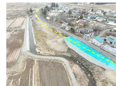
工事が進む現道拡幅区間
