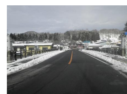
舗装復旧 橋面補修の完成
