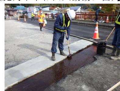
橋梁端部の漏水防止
