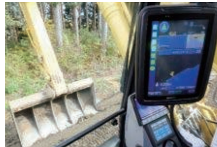
ICT建設機械による施工状況
