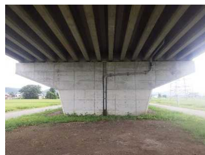
橋脚の巻立工法による耐震化
