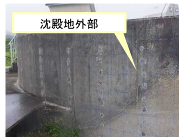
せん断補強筋による施設の耐震化
