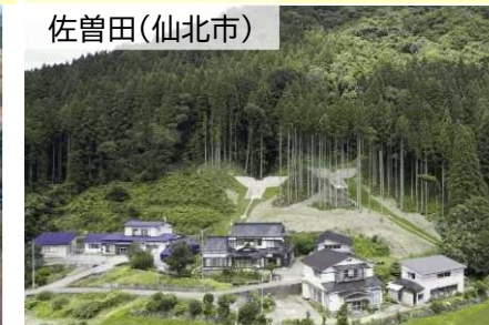
治山施設整備による対策
