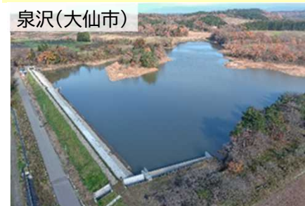
防災重点農業用ため池の改修工事
