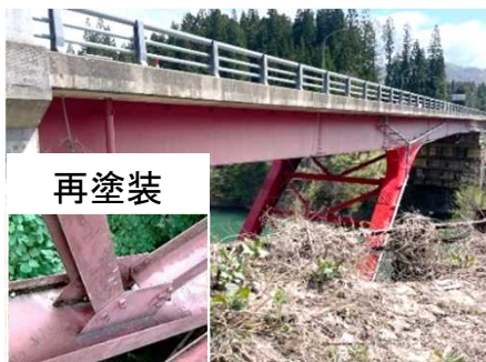
再塗装 道路施設(橋梁の桁再塗装)
