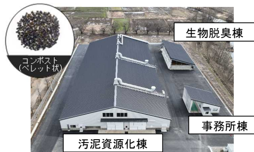
県南地区広域汚泥資源化事業 (R7年度 運用開始)
