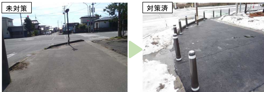
ポラード等の設置
