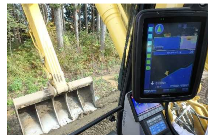
ICT建設機械による施工状況
