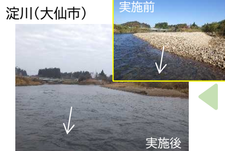
伐木・河道掘削の実施
