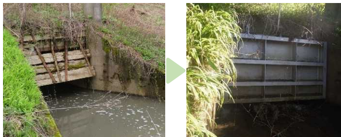
河川施設(樋管のゲート更新)
