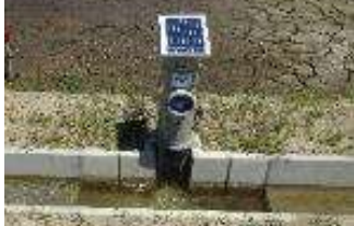
遠隔操作型給水栓（開水路用）
