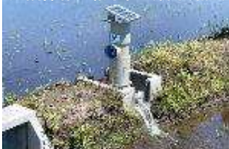
遠隔操作型給水栓（開水路用）
