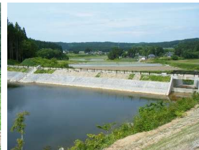
ため池の改修
