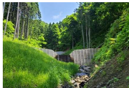
治山ダム工事
