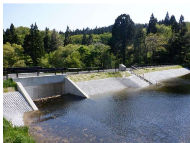
防災重点農業用ため池の改修
