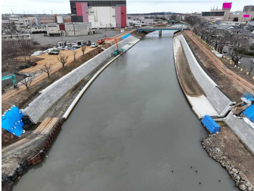
一級河川 太平川（秋田市） 河川改修工事
