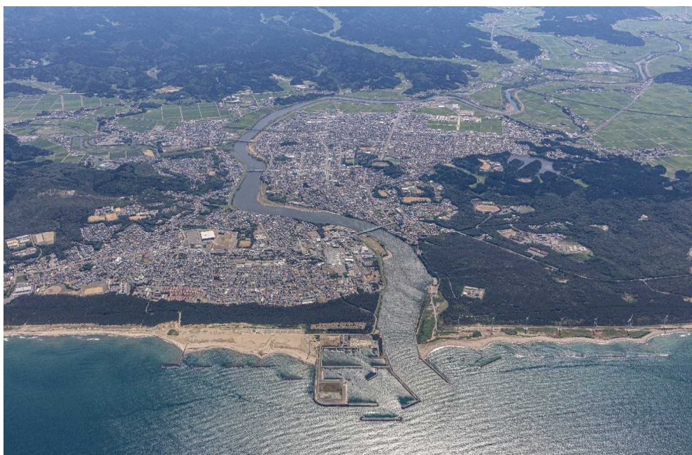
本荘港全景(令和7年7月撮影)
