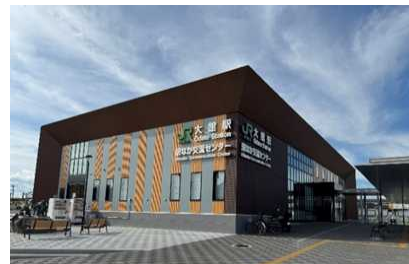
大館市[合築駅舎・地域交流センター]
