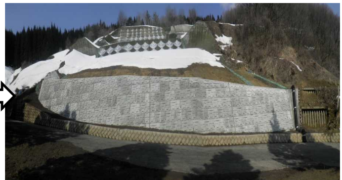
復旧工事完了
