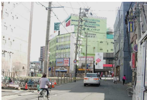
【歩道がなく、一方通行及び電柱が乱立しており 街路空間の改善必要】
