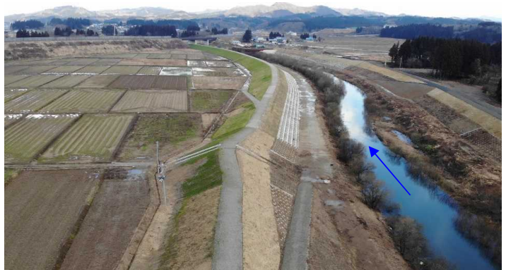
復旧工事完了
