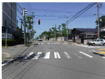
▲川尻総社通り線(現況)
