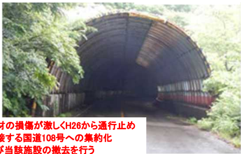
R8年度:撤去工事
