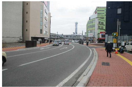
【歩道設置、道路拡幅による両側交互通行及び無電柱化 による安全安心な街路空間を確保】
