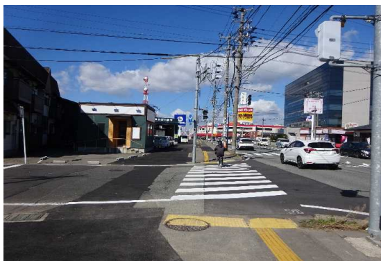
【進捗状況】 新屋土崎線(秋田市)
