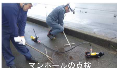
マンホールの点検
