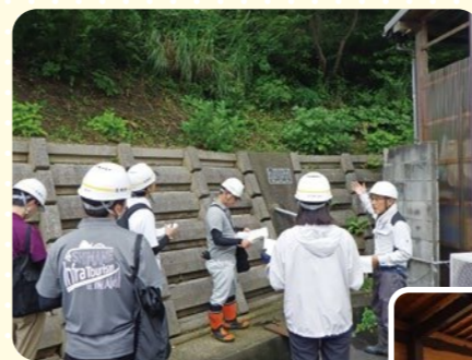
◀治山施設の点検
