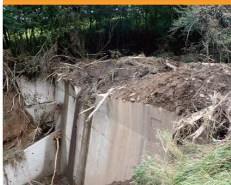
治山ダムが土砂や流木の流出を防止
