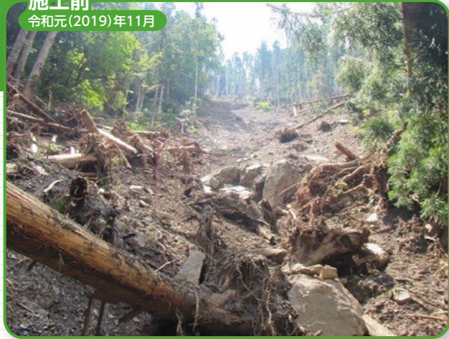
施工完了 令和6(2024)年7月
