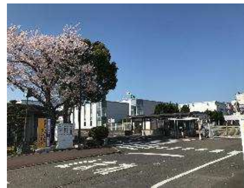
福井県敦賀市 東洋紡敦賀事業所内の 工場で生産(国産繊維)
