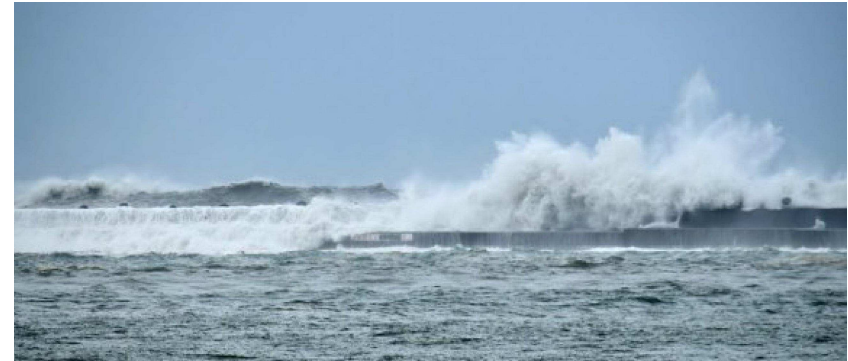
防波堤により荒天時の波浪等から港内静穏度を確保
