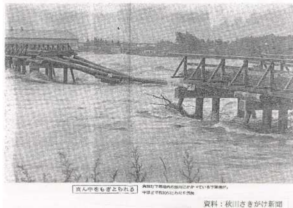
写真 5 昭和 47 年 7 月洪水被害の様子
