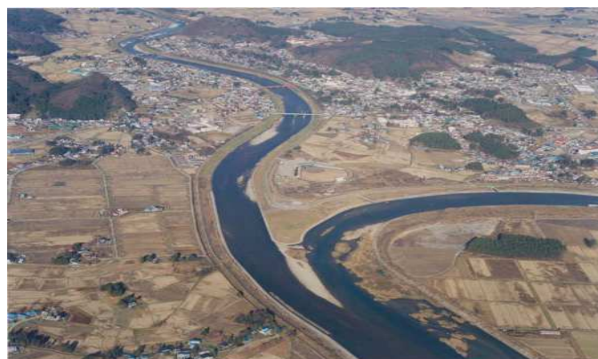
写真 2 玉川と檜木内川との合流点の改修状況
