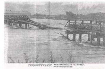
写真5 昭和47年7月洪水被害の様子
