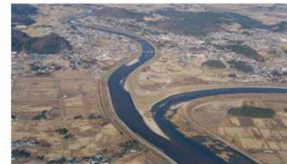
写真2 玉川と 桧木内川 との合流点の改修状況
