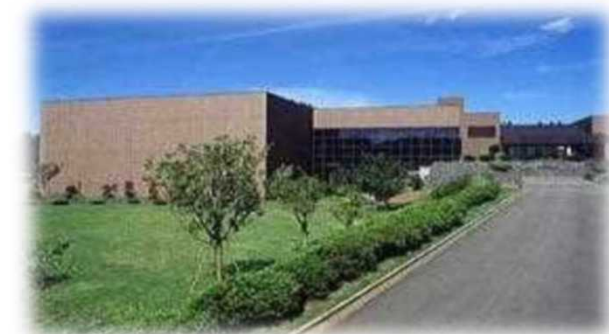
◎県立博物館 昭和49年建設（51年経過）
