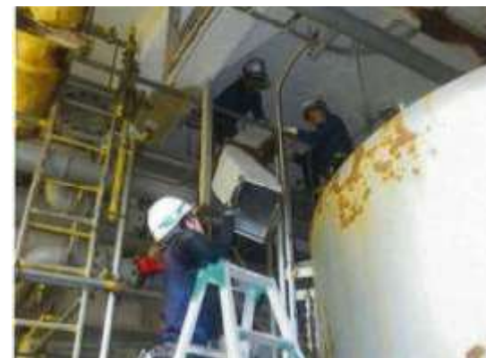
経年劣化が進んだ排気ダクトの更新作業
