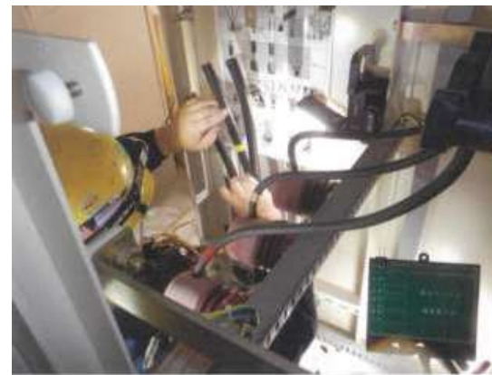
高圧ケーブルの更新作業
