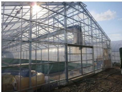
【部会で整備したねぎ育苗施設】
