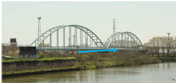
送水管二系統化（茨島水管橋）
