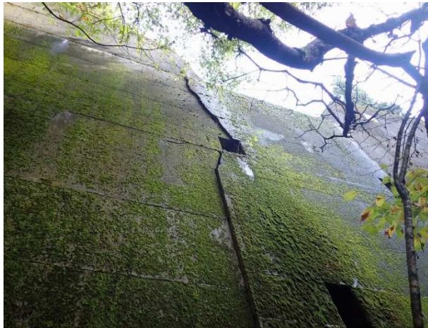
砂防堰堤損傷例
