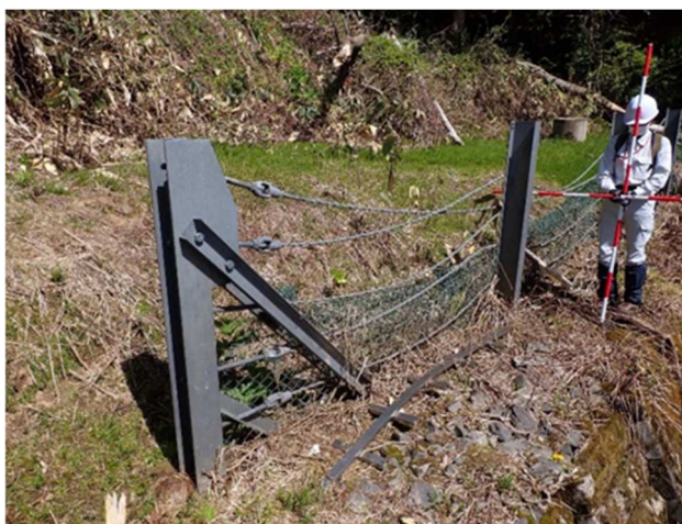
急傾斜地崩壊防止施設損傷例
