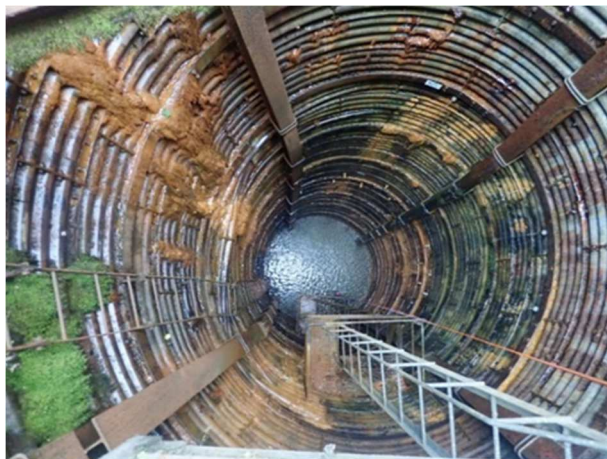
地すべり防止施設損傷例
