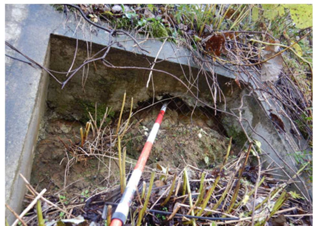
急傾斜地崩壊防止施設損傷例
