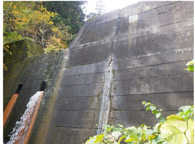
砂防堰堤損傷例
