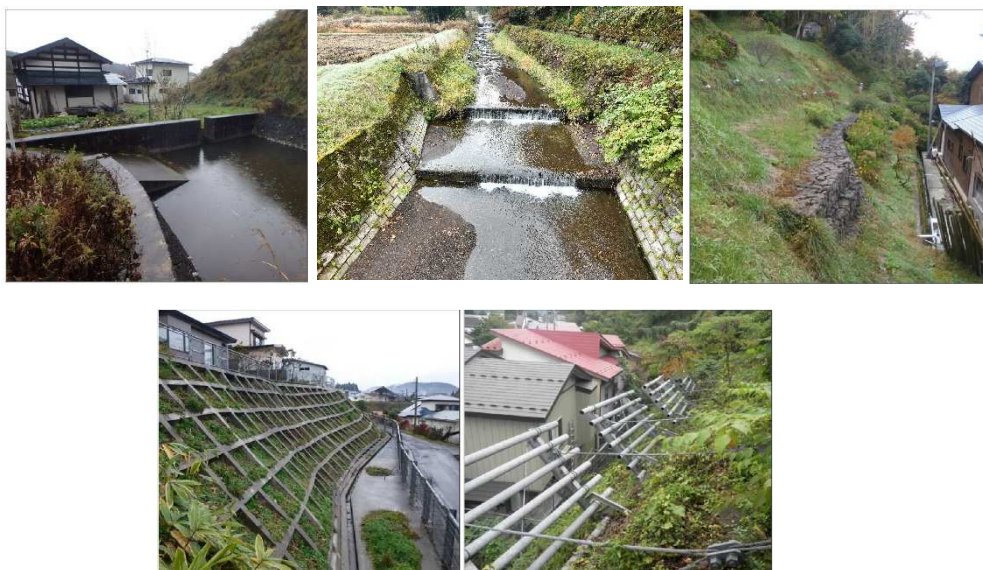
（左上から砂防堰堤、溪流保全工、地すべり防止施設、 左下から急傾斜地崩壊防止施設、雪崩防止施設）
