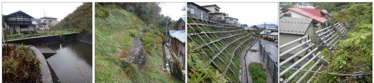
（左から、砂防堰堤、地すべり防止施設、急傾斜地崩壊防止施設、雪崩防止施設）
