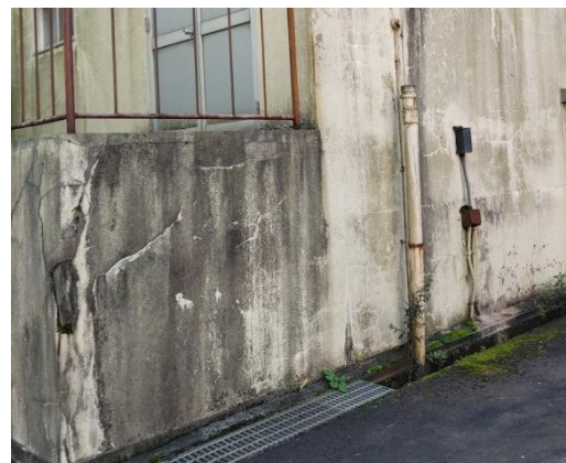
写 3-2-(2) 土木施設損傷例：利水ゲート室の階段部クラック
