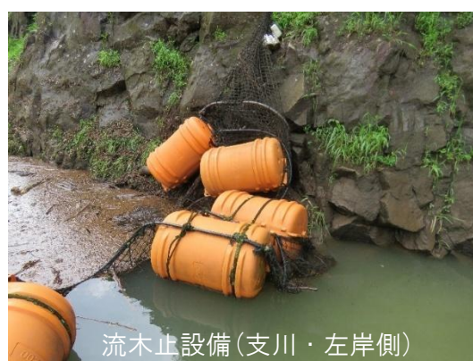
写 3-4-(1) 機械設備損傷例
