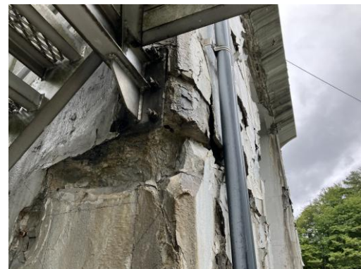
写 3-2-(1) 土木施設損傷例
