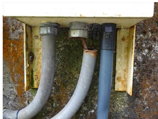
写 3-6-(2) 電気通信設備損傷例
