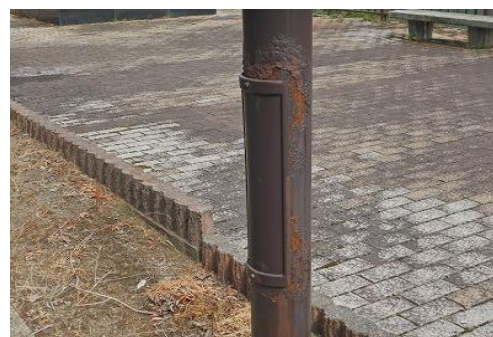
写 3-6-(2) 電気通信設備損傷例
