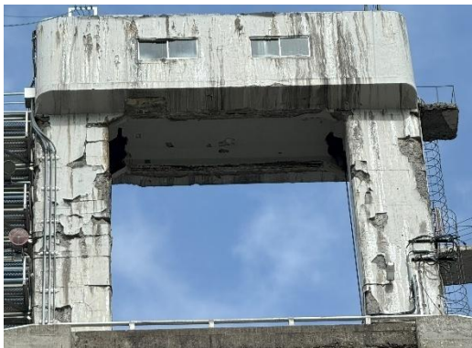
写 3-2-(1) 土木施設損傷例
