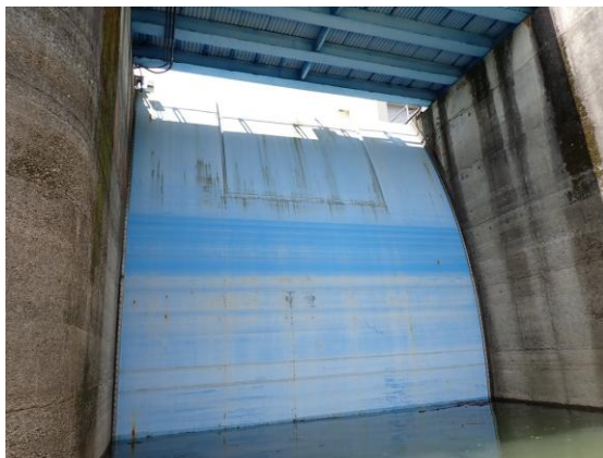
写 3-4-(1) 機械設備損傷例
