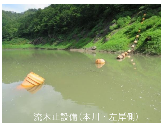
写 3-4-(1) 機械設備損傷例
