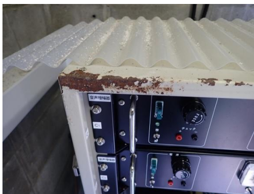
写 3-6-(1) 電気通信設備損傷例
