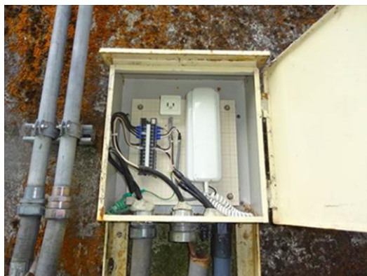
写 3-6-(2) 電気通信設備損傷例
