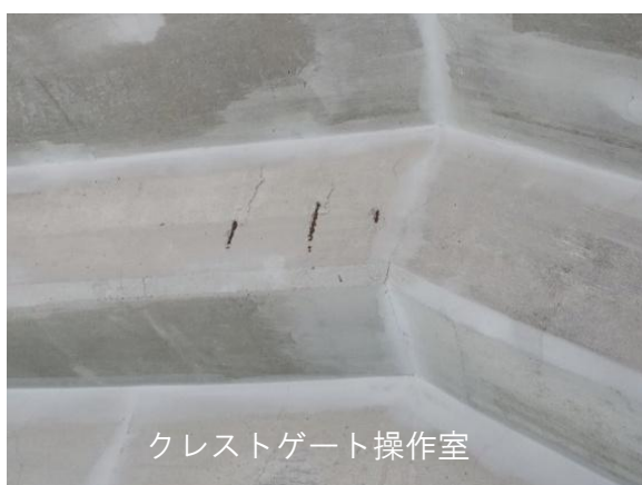
写 3-2-(2) 土木施設損傷例
