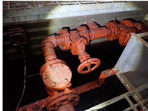
写 3-4-(2) 機械設備損傷例
