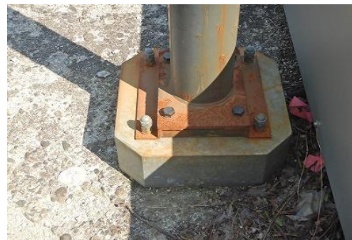
写 3-6-(1) 電気通信設備損傷例
