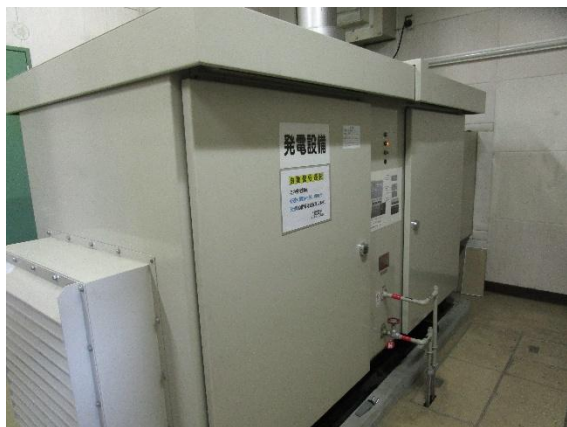
写 3-6-(1) 電気通信設備一部更新例
