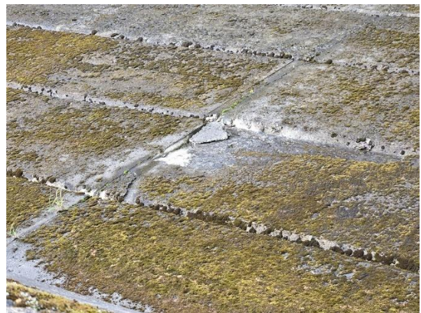
写 3-2-(1)土木施設損傷例
