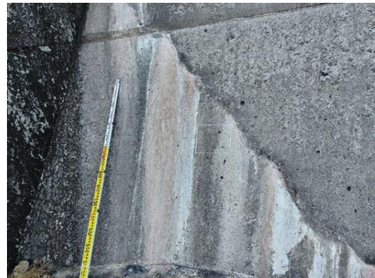
写 3-2-(1) 土木施設損傷例：堤体下流面クラック・エフロレッセンス
