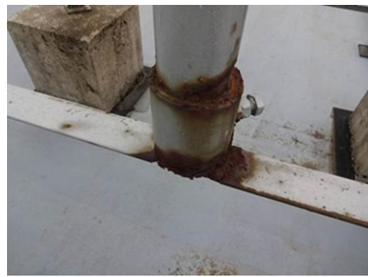
写 3-6-(1) 電気通信設備損傷例
