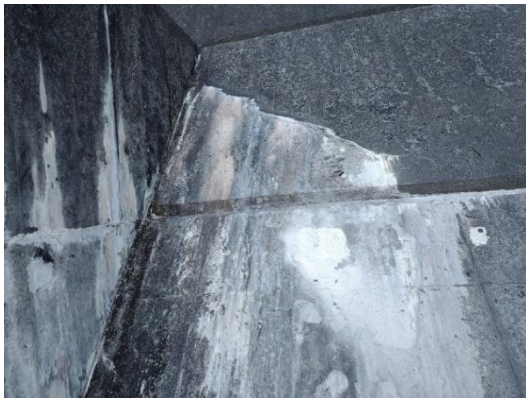
写 3-2-(1) 土木施設損傷例：堤体下流面クラック・エフロレッセンス
