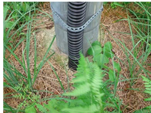
写 3-6-(1) 電気通信設備損傷例
