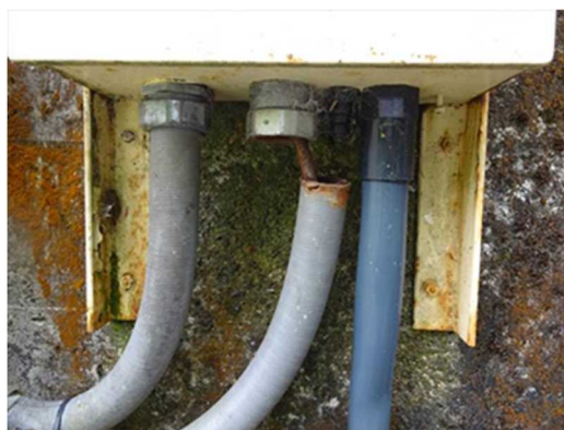
写 3-6-(2) 電気通信設備損傷例
