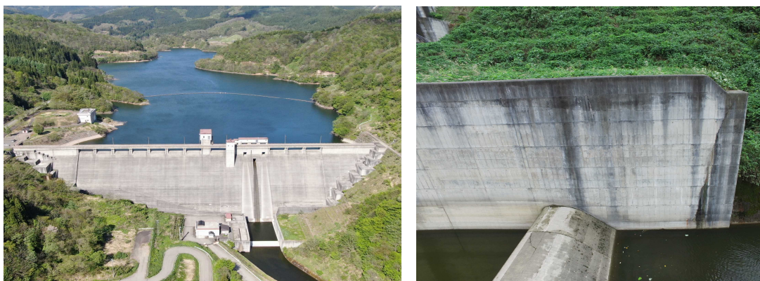
写 2-1-(1)土木施設の例
