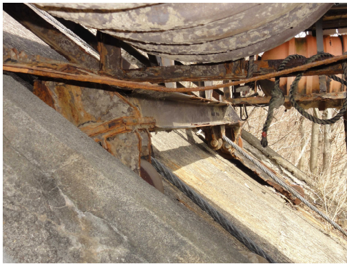
写 3-4-(1) 機械設備損傷例
