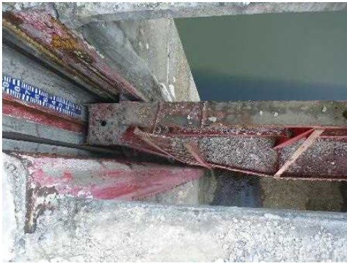
写 3-4-(1) 機械設備損傷例
