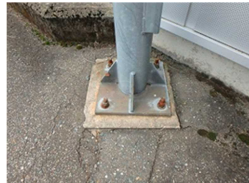
写 3-6-(2) 電気通信設備損傷例
