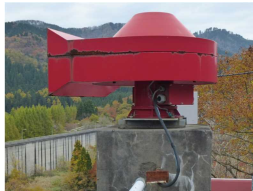
写 3-6-(2) 電気通信設備損傷例
