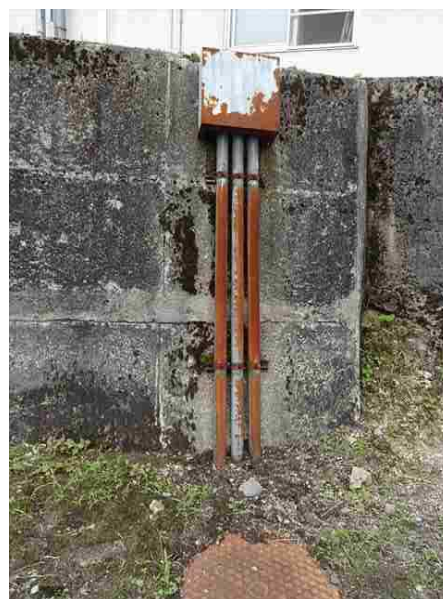
写 3-6-(1) 電気通信設備損傷例
