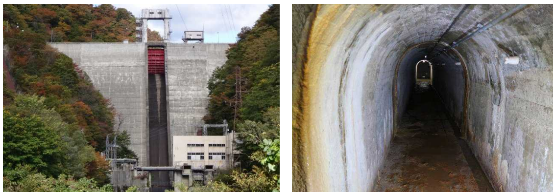
写 2-1-(1)土木施設の例
