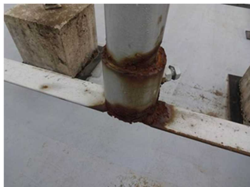
写 3-6-(1) 電気通信設備損傷例
