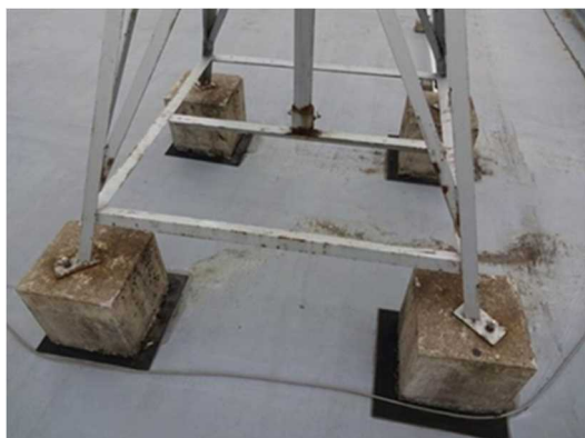
写 3-6-(1) 電気通信設備損傷例
