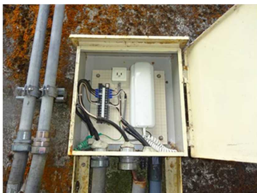
写 3-6-(2) 電気通信設備損傷例
