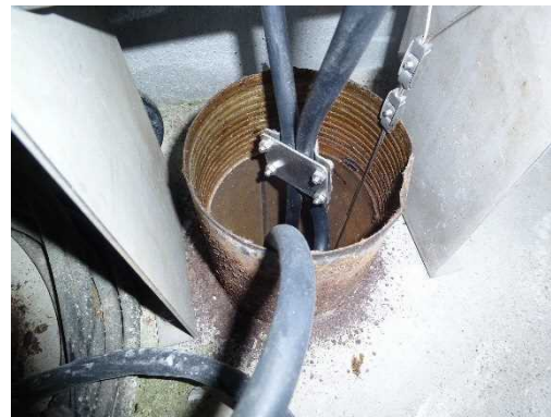
写 3-6-(1) 電気通信設備損傷例
