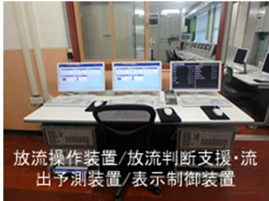
写 2-1-(3) 電気通信設備の例
