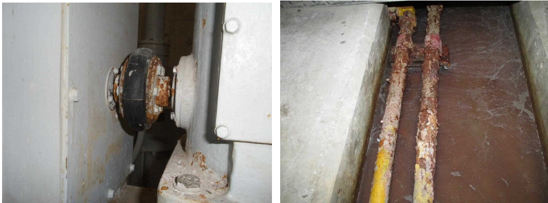
写 3-4-(1) 機械設備損傷例
