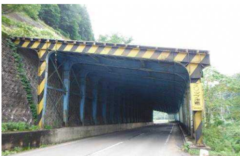
写-2.2.3 スノーシェッドの例
