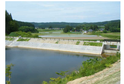
〔ため池の改修〕
