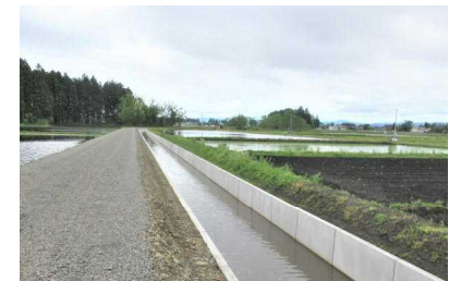
〔用排水路の整備〕
