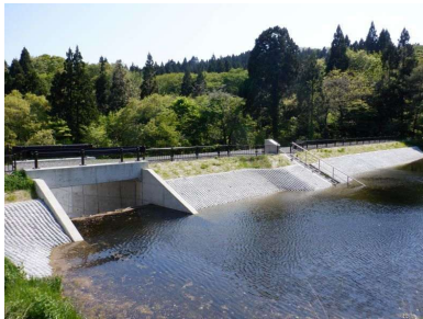
防災重点農業用ため池の改修
