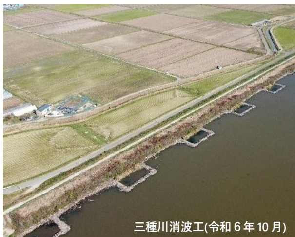
図 39 消波工の設置状況
