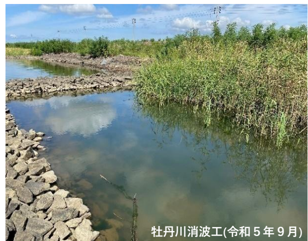
図 40 消波工内の植生の状況
