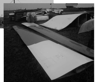
風力発電設備と 解体後のブレード
