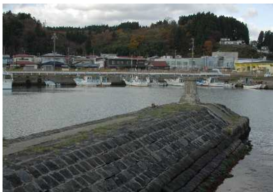
写真10 船川港 第二船入場防波堤
