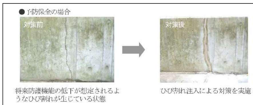
図 10 補修の例
