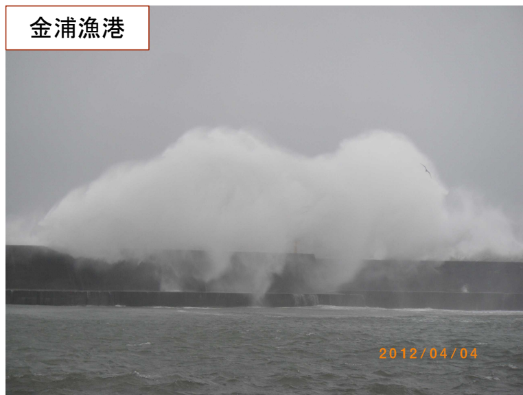
平成24年4月の波浪による 被災状況写真
