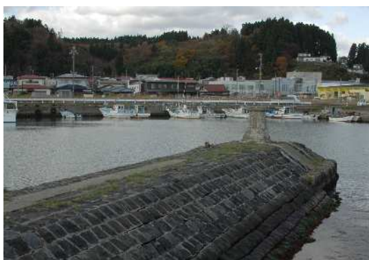
写真10 船川港 第二船入場防波堤
