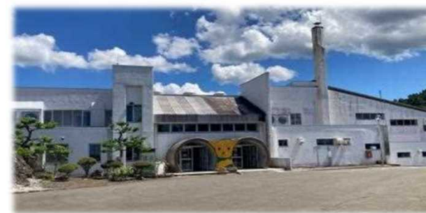
◎大館少年自然の家 昭和49年建設（51年経過）
