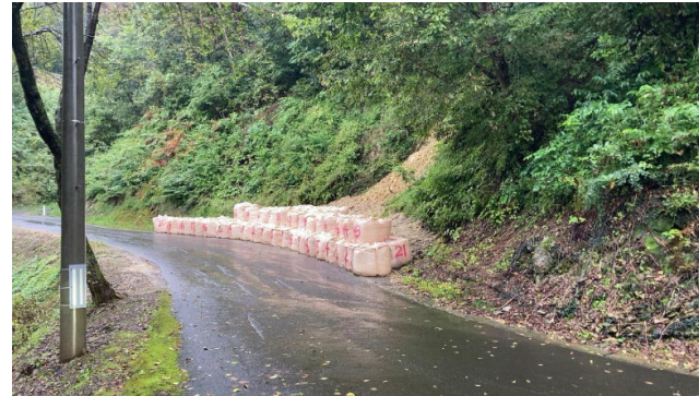
大型土嚢設置による安全対策
