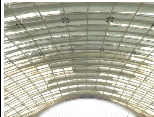
膜屋根下から見た堆雪状況
