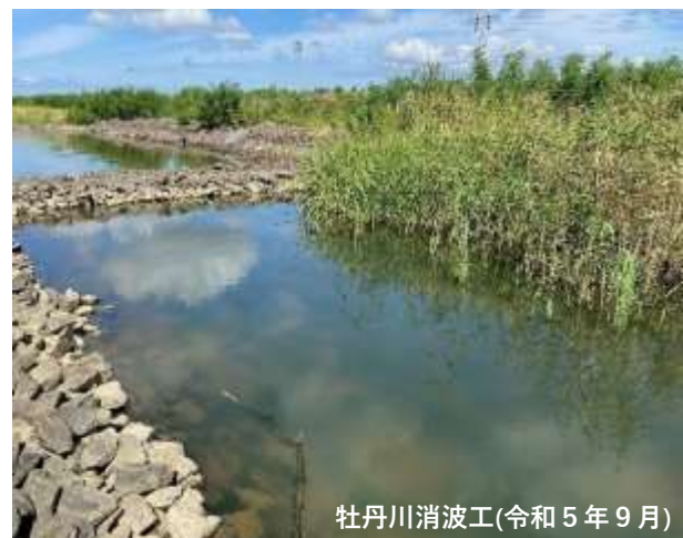
図 40 消波工内の植生の状況
