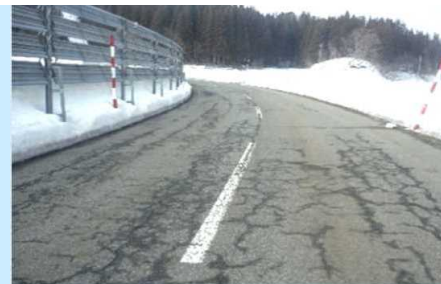
降雨・融雪に伴う舗装損傷(全面に渡る損傷)
