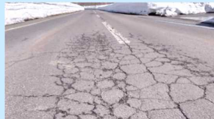
降雨・融雪に伴う舗装損傷(全面に渡る損傷)
