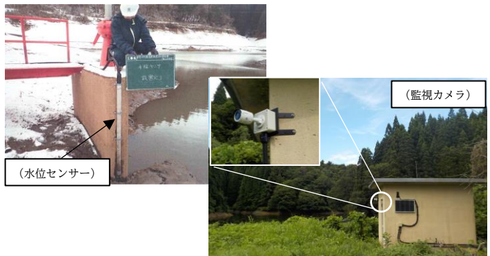
＜水位計システムを導入した滝の沢ため池（秋田市）＞
