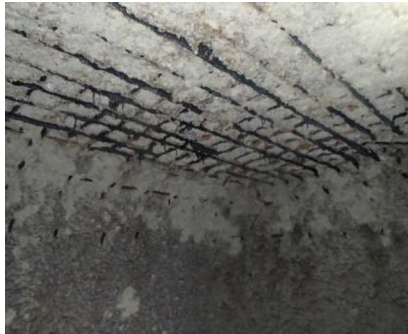
鉄筋が腐食したマンホール内部
