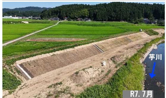
河川改修事業 ③芋川(由利本荘市)
