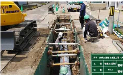
耐震性能を有する2条目管の整備
