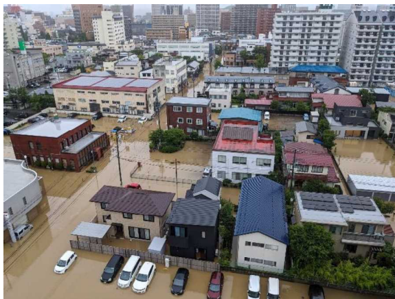
秋田駅西地区の冠水状況(令和5年7月)
