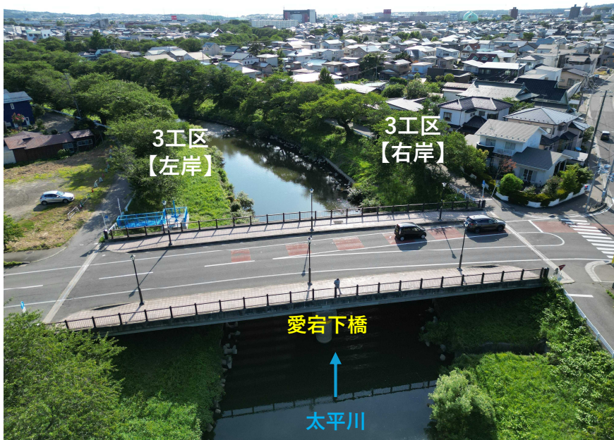
【写真①】 愛宕下橋の下流側【着手前】
