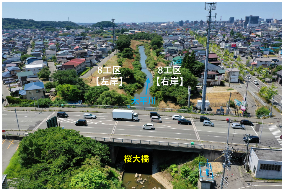
【写真①】 桜大橋の下流側 【着手前】
