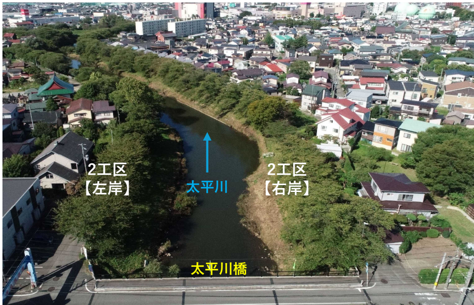
【写真①】 太平川橋の下流側【着手前】
