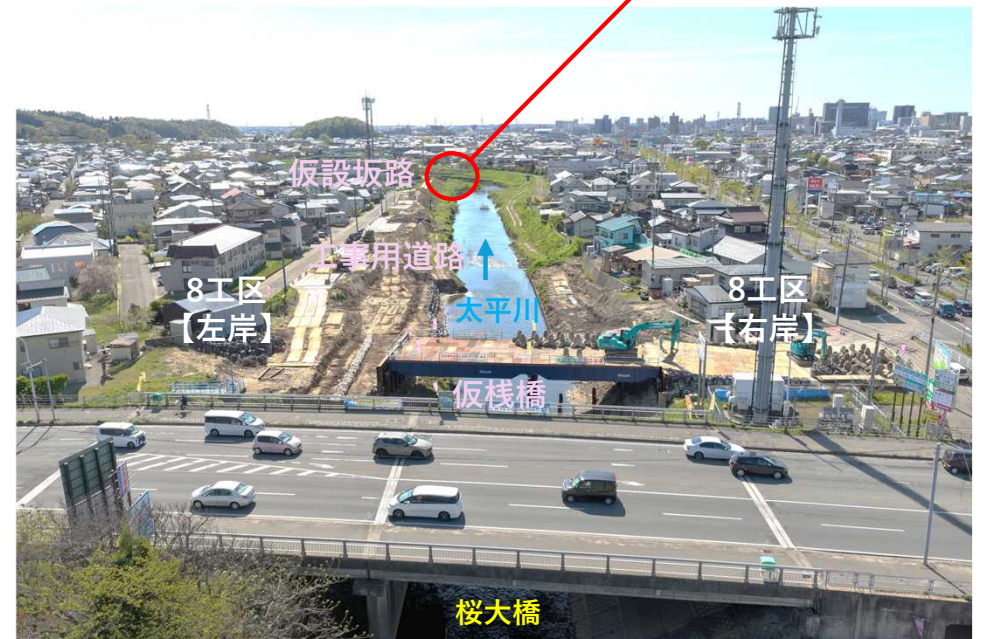
【写真②】 桜大橋の下流側 【R8.4月撮影】
