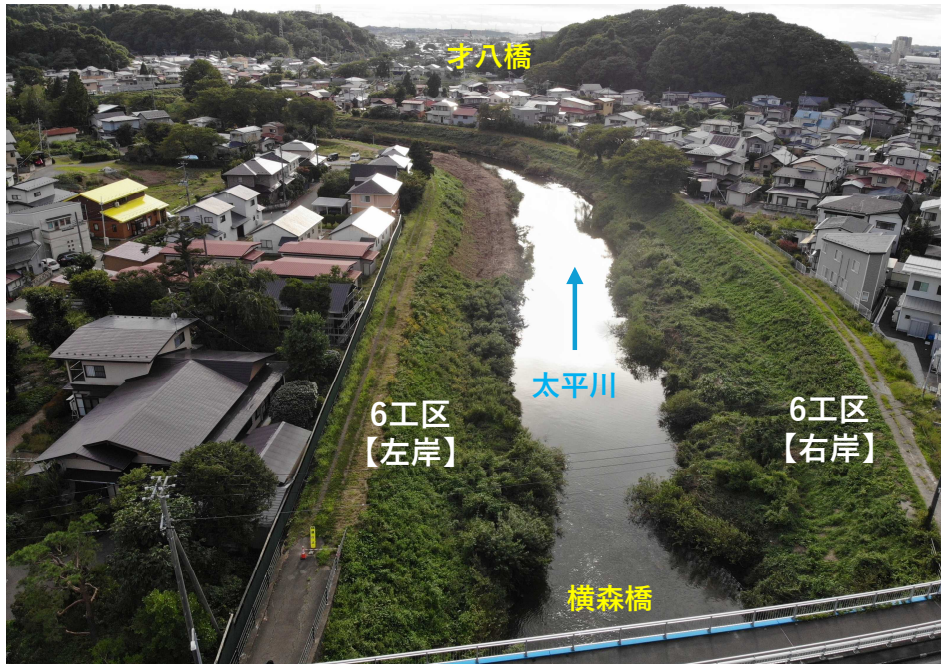
【写真①】 横森橋下流側 【着手前】
