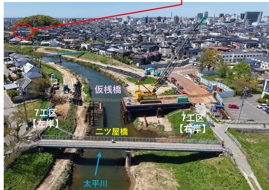
【写真②】ニツ屋橋の下流側 【R8.4月撮影】
