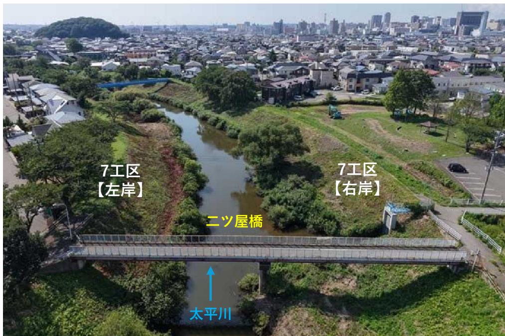
【写真①】ニツ屋橋の下流側 【着手前】
