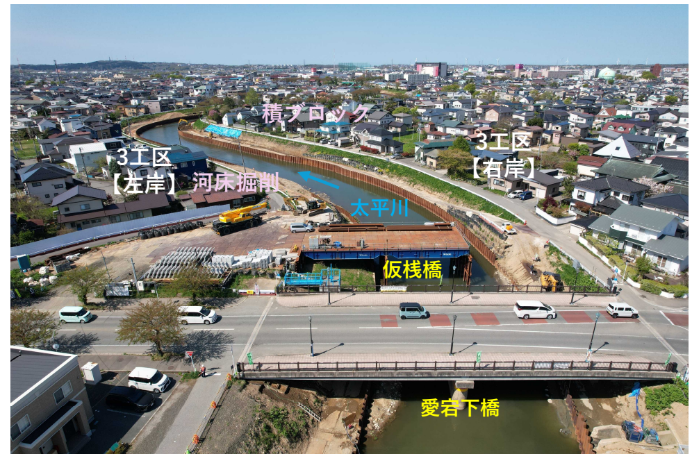
【写真②】 愛宕下橋の下流側【R8.4月撮影】
