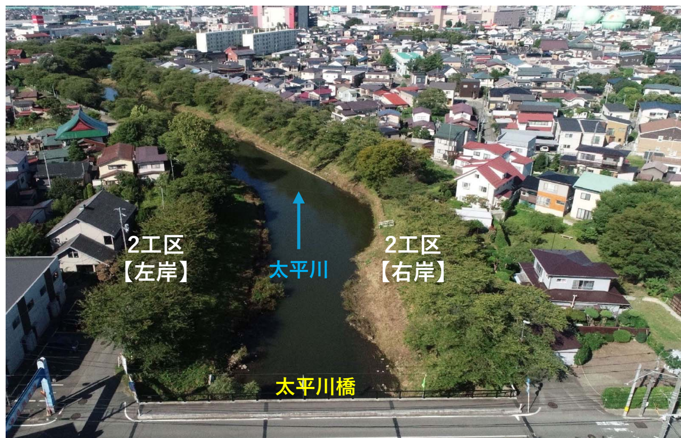
【写真①】 太平川橋の下流側【着手前】
