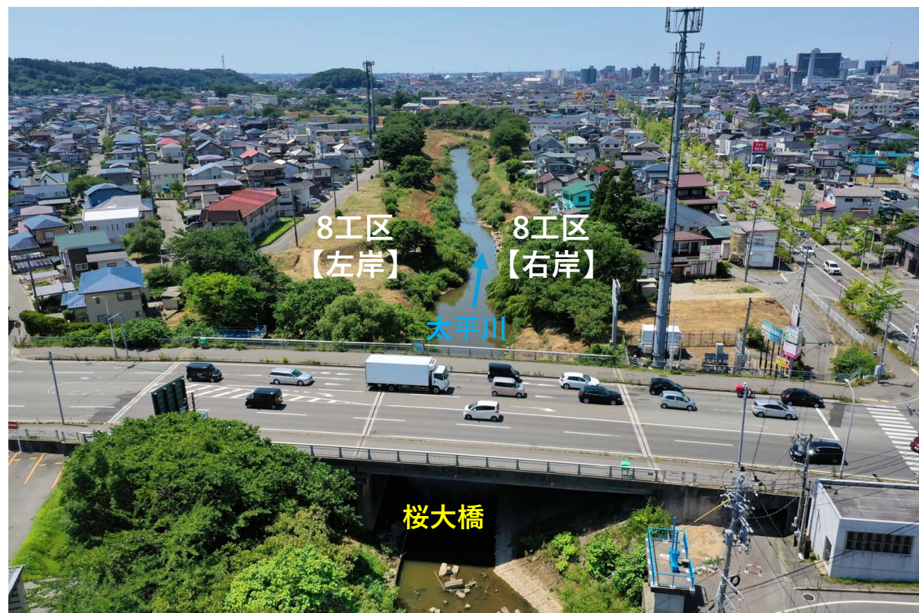
【写真①】 桜大橋の下流側 【着手前】
