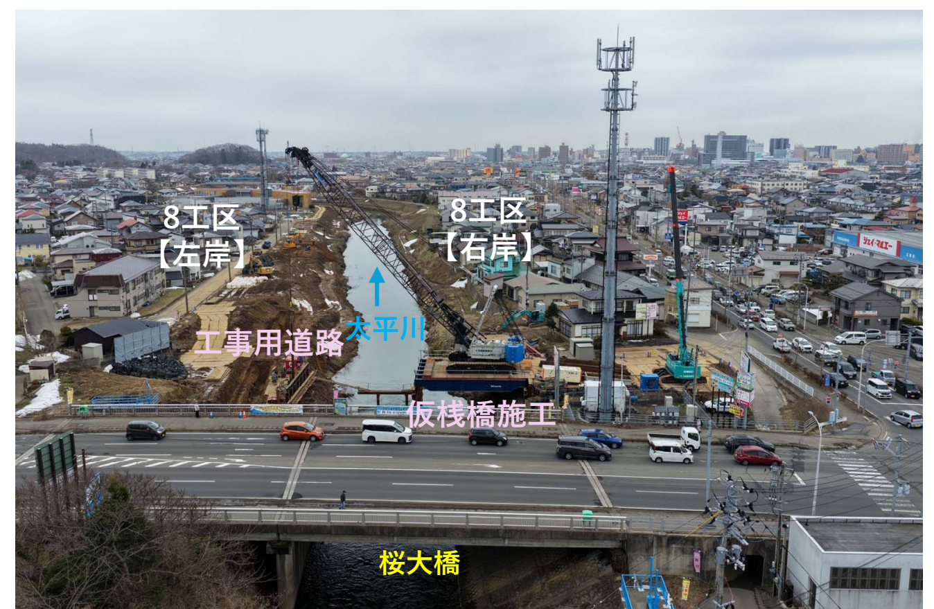
【写真②】 桜大橋の下流側 【R8.2月撮影】
