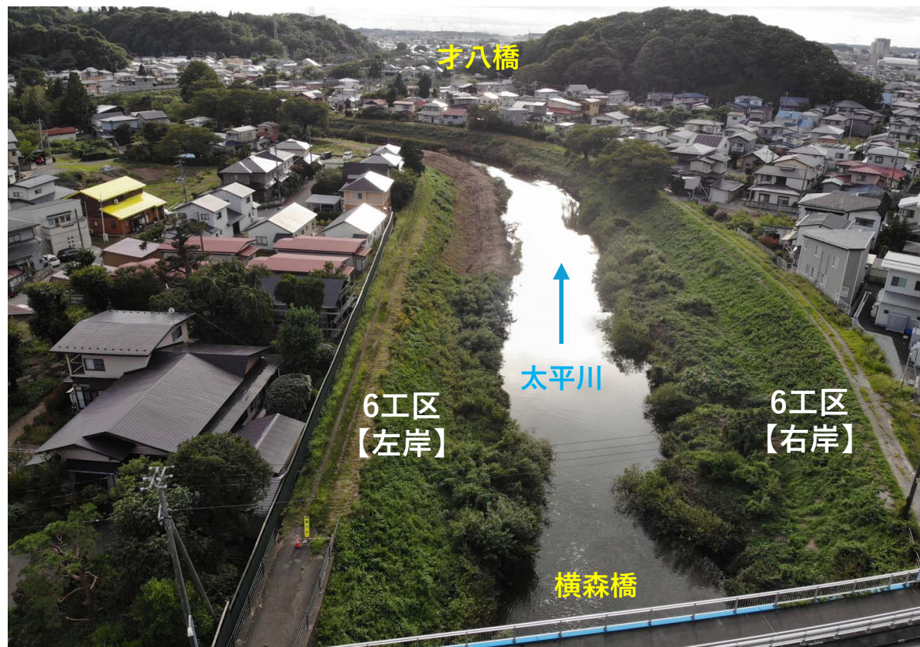
【写真①】 横森橋下流側 【着手前】
