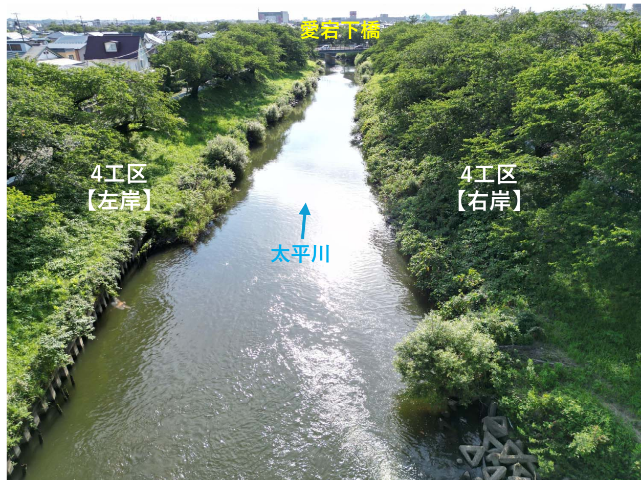
【写真①】 愛宕下橋～百石橋【着手前】
