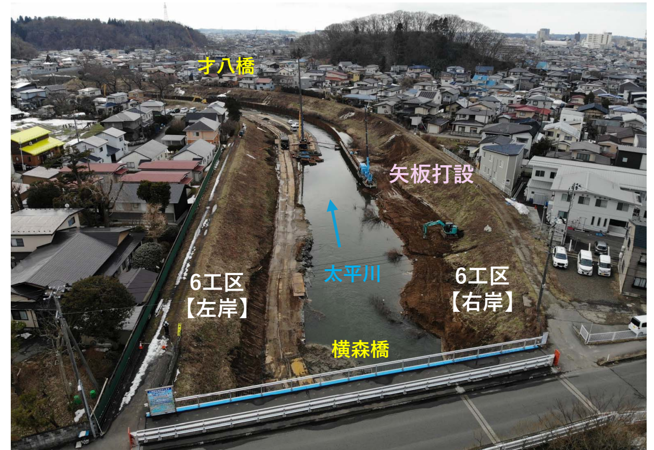
【写真②】 横森橋下流側 【R8.2月撮影】
