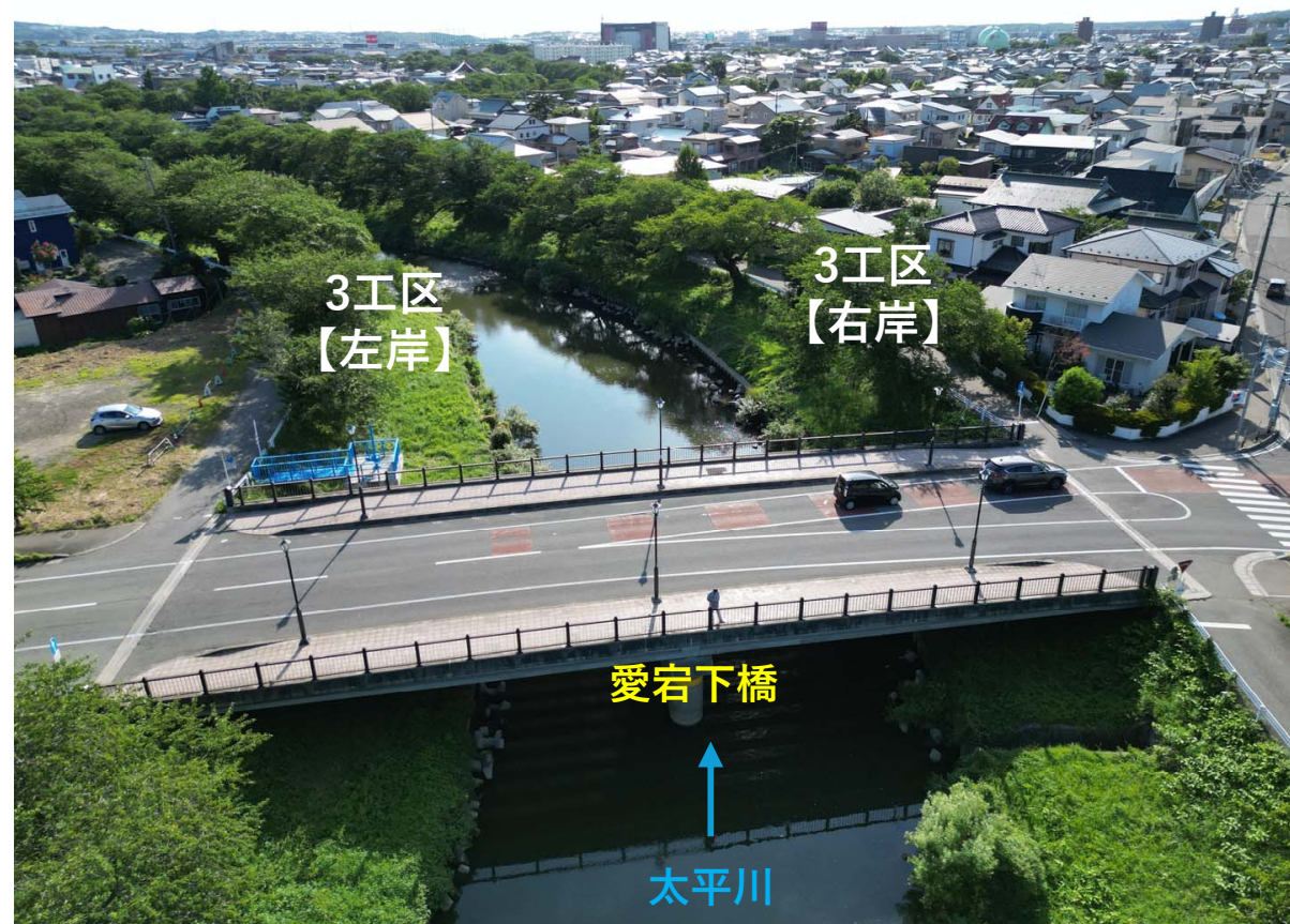
【写真①】 愛宕下橋の下流側【着手前】
