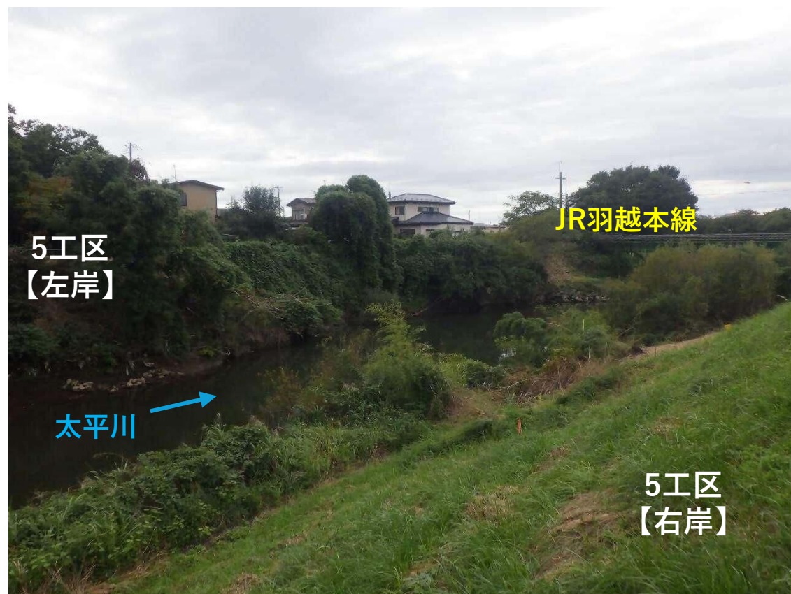
【写真①】 JR羽越本線の上流側【着手前】
