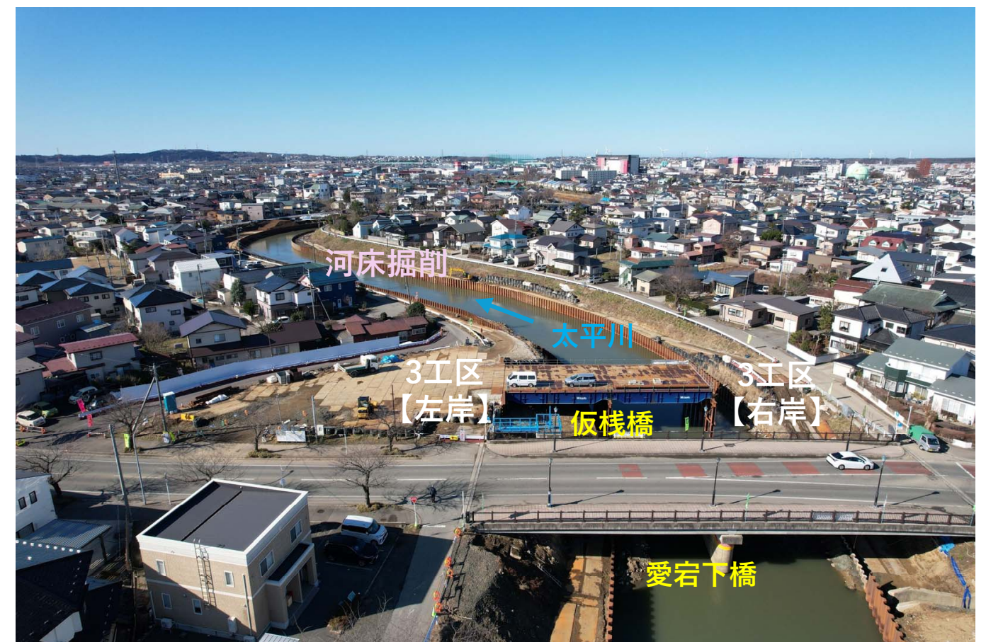
【写真②】 愛宕下橋の下流側【R8.2月撮影】
