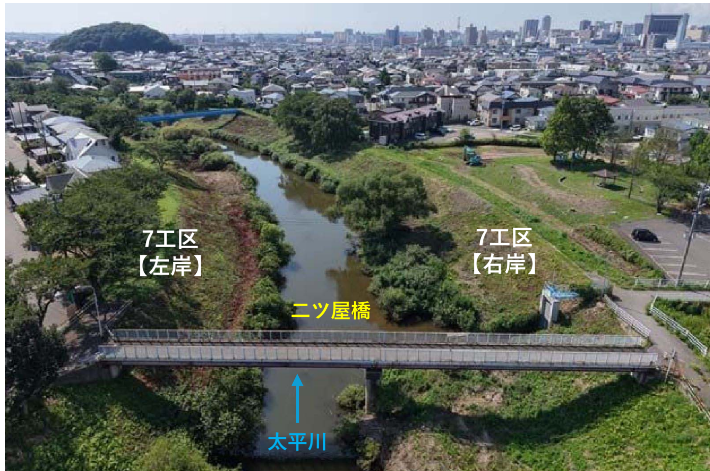
【写真①】二ツ屋橋の下流側 【着手前】
