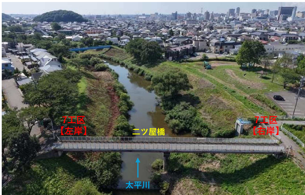
【写真①】ニツ屋橋の下流側 【着手前】
