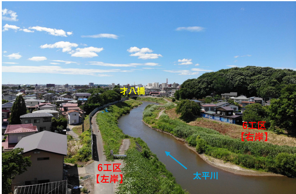
【写真①】 才八橋上流側 【着手前】
