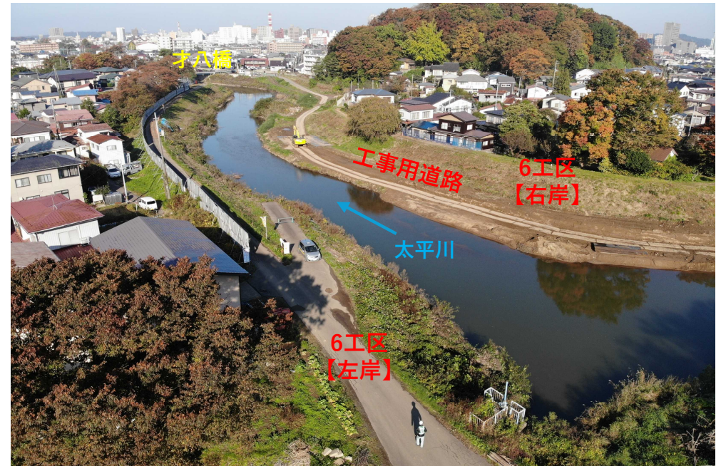
【写真②】 才八橋上流側 【R7.10月撮影】
