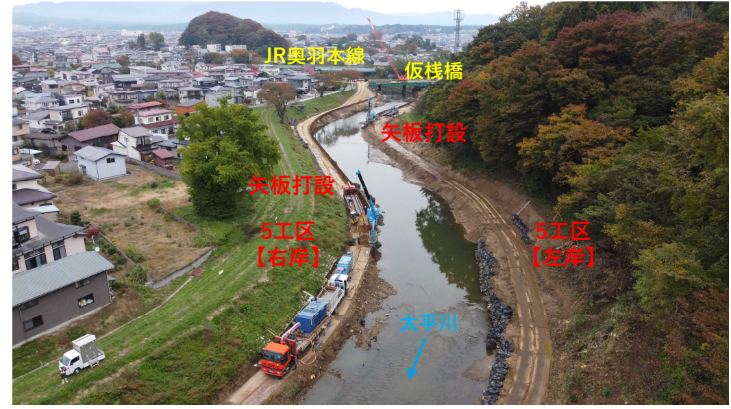
【写真②】 JR奥羽本線の下流側【R7.10月撮影】
