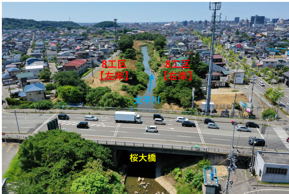
【写真①】 桜大橋の下流側 【着手前】
