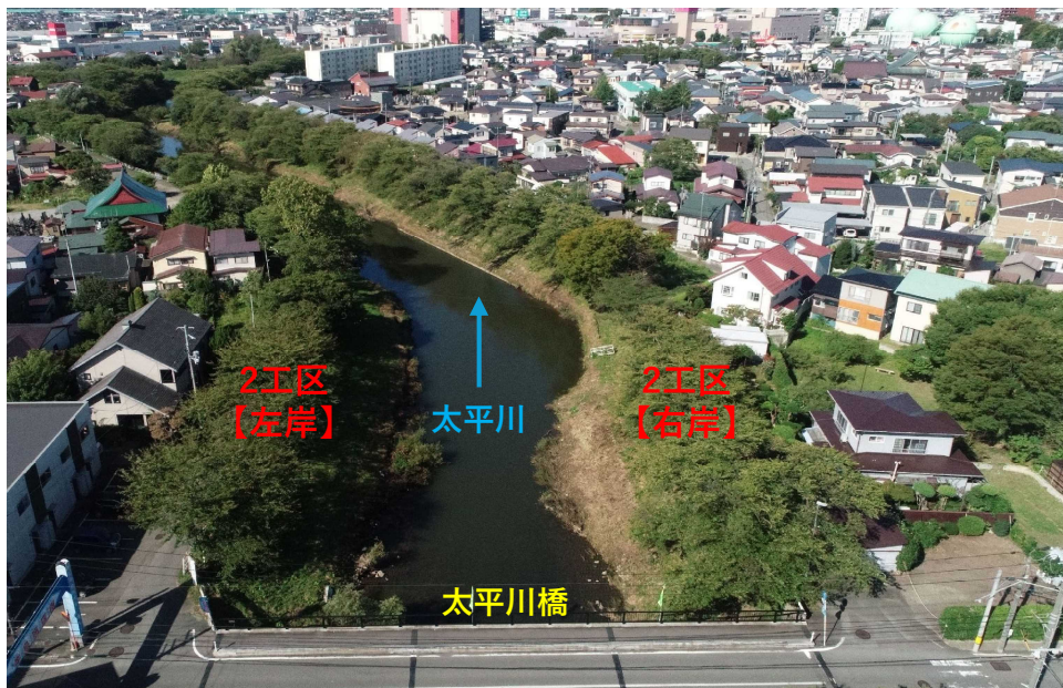
【写真①】 太平川橋の下流側【着手前】
