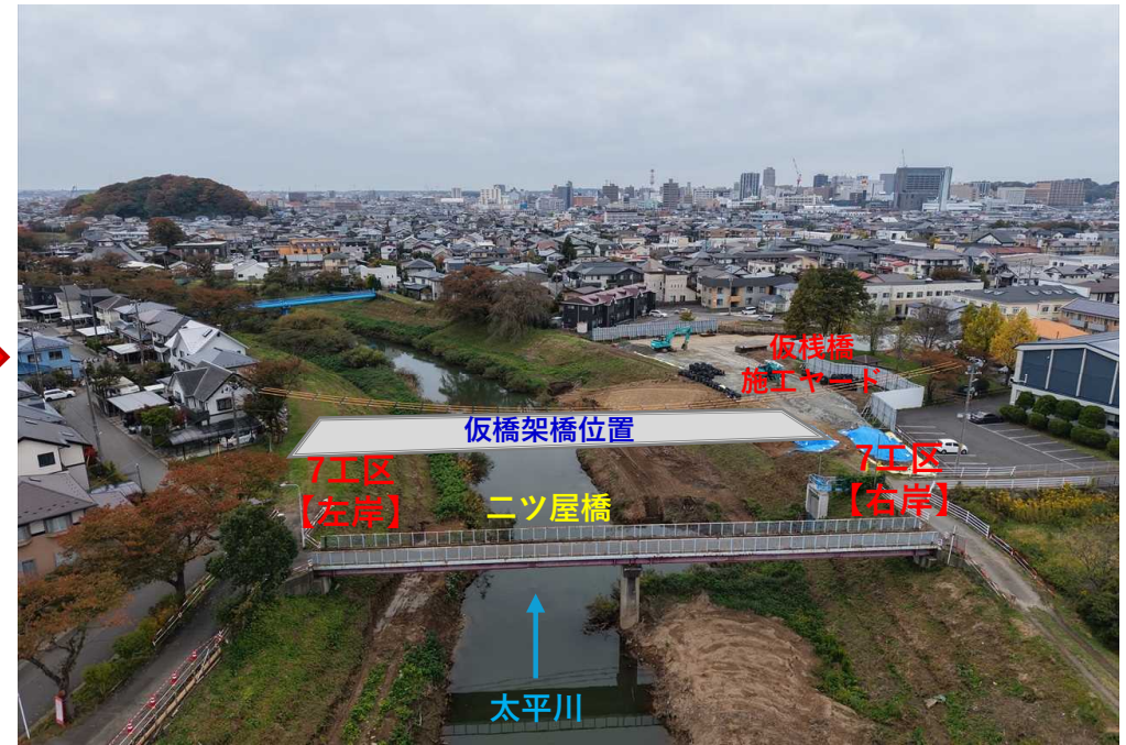
【写真②】ニツ屋橋の下流側 【R7.10月撮影】
