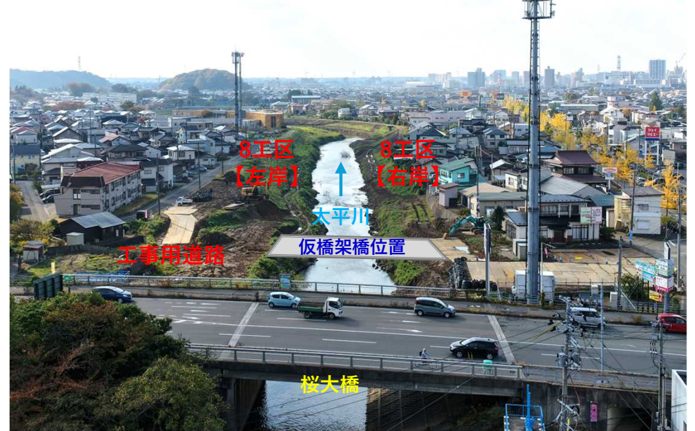
【写真②】 桜大橋の下流側 【R7.10月撮影】
