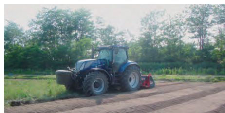
下内川西地区（大館市） ストーンクラッシャーによる石礫破碎
