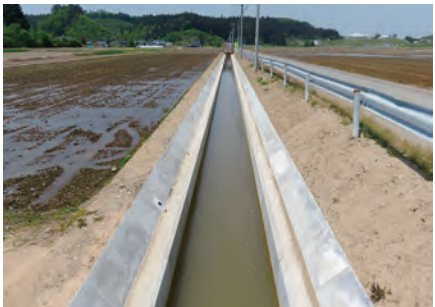
排水路の整備
