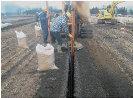
暗渠排水の整備
