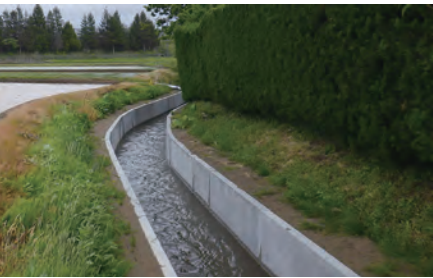
大川堤ノ内地区（五城目町）
