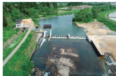
新上堰頭首工（施工後）
