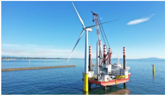
洋上風力発電設備の設置工事 (提供:秋田洋上風力発電(株))
