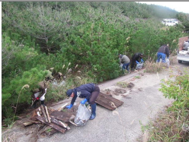
撤去作業（第 2 班）
