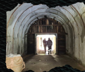
女木内通気・換気 作業横坑見学
