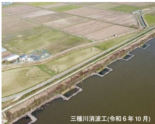
図39 消波工の設置状況
