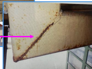
押送フレームの亀裂
