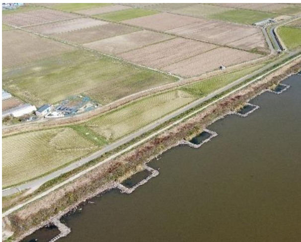
図 39 消波工の設置状況
